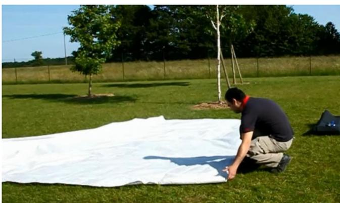
3. Installation du géotextile de protection (il est recommandé de le fixer à l'aide d'agrafes pour faciliter le dépliage de la citerne)
