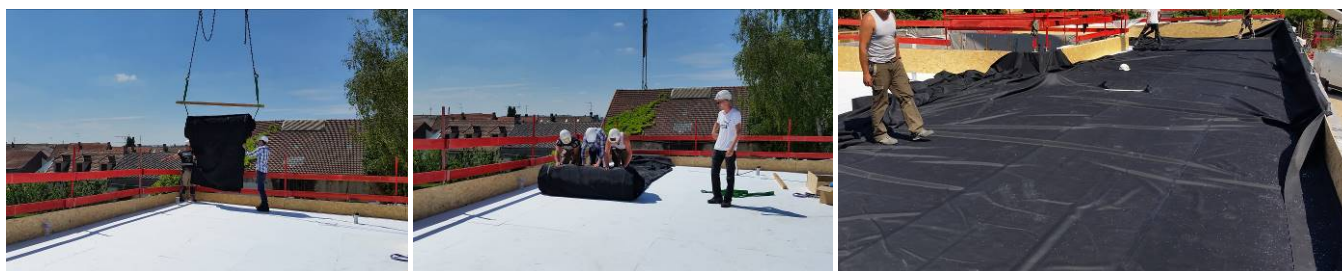
Photo 23 – Déroulement d'une membrane de grande surface à l'aide d'un engin de levage
