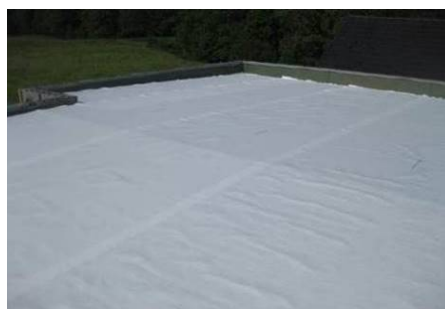
Photo 15 – Pose directe sur élément porteur en indépendance
