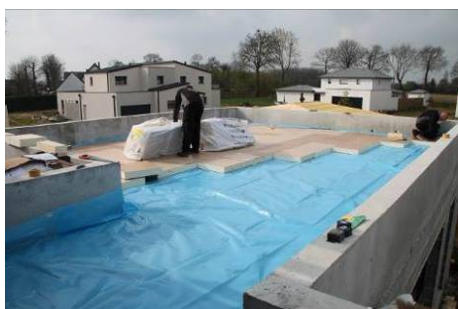
Photo 14 – Pose directe sur isolant rigide en indépendance (pare-vapeur PE bleu en dessous, côté face chaude)
