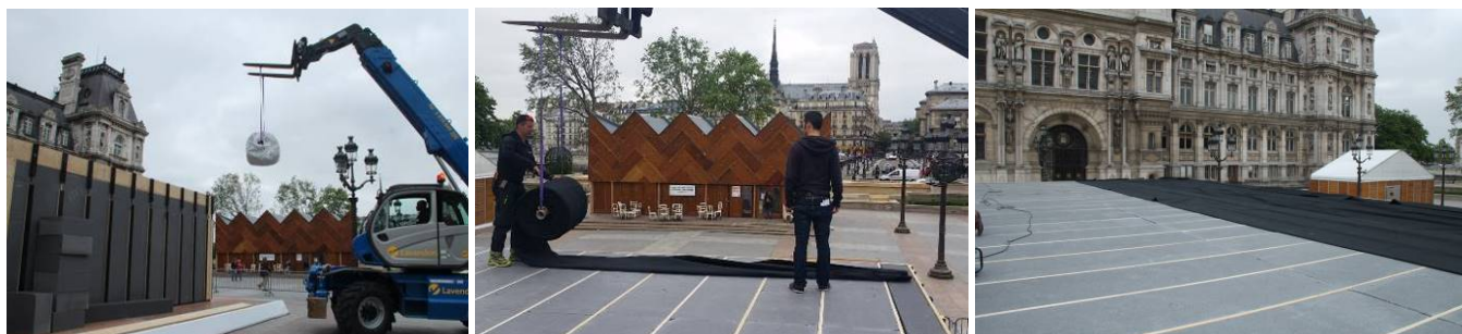
Photo 24 – Déroulement d'une membrane EPDM préfabriquée FLEXIRUB (170 m 2 )
