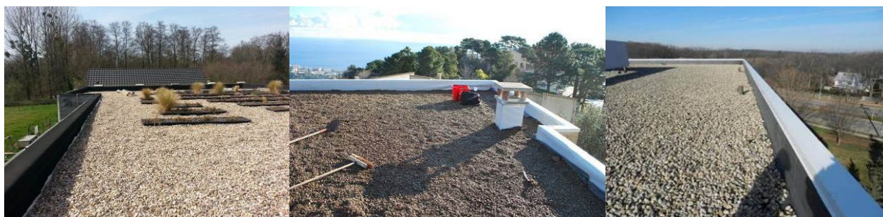
Photo 32 – Illustration de revêtement d'étanchéité en Indépendance sous protection meuble
