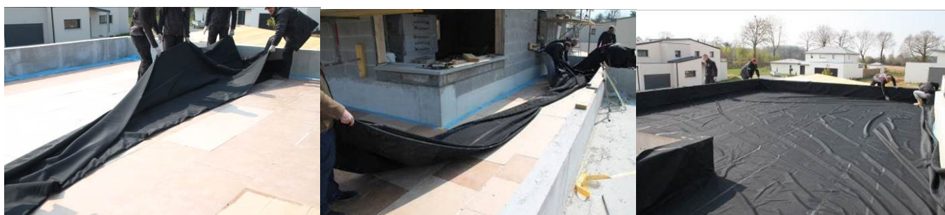
Photo 25 – Déroulement d'une membrane EPDM préfabriquée FLEXIRUB (160 m 2 )
