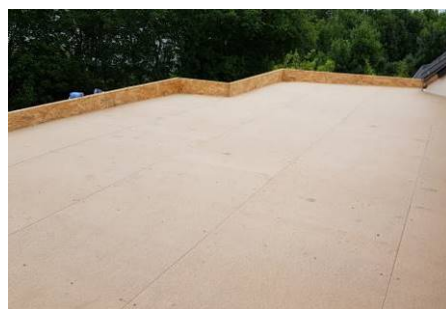
Photo 16 – Pose directe sur élément porteur en adhérence
