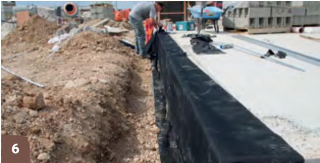
Ajustement de la protection de soubassement en EPDM avant fixation
