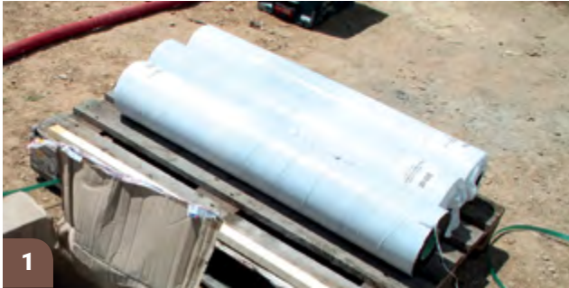
Livraison de la protection de soubassement en EPDM
