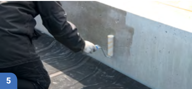
5 Encollage des relevés d'étanchéité
