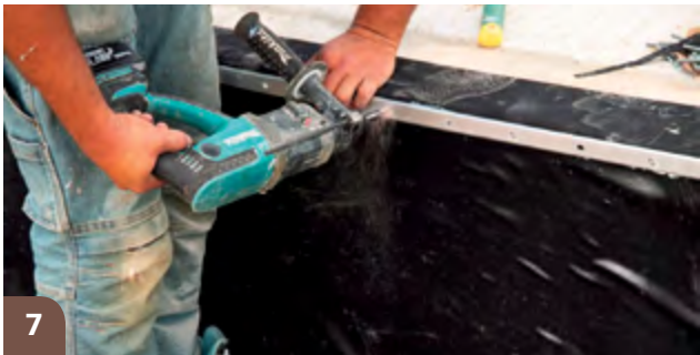
Positionnement du profil de fixation et perçage
