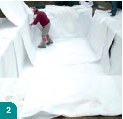
2 Pose du géotextile de protection extérieure
