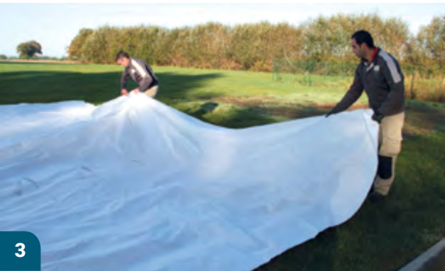
Pose du géotextile de protection avec agrafages
