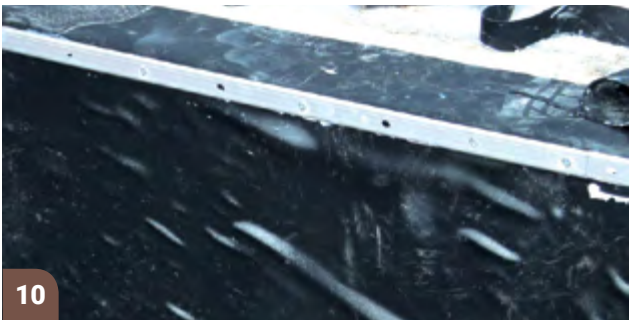
Étanchéité de la fondation finalisée
