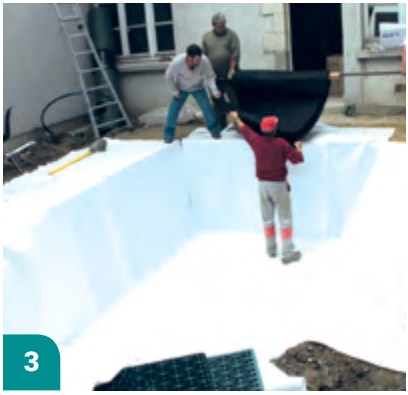
3 Déroulement de la géomembrane EPDM 3D
