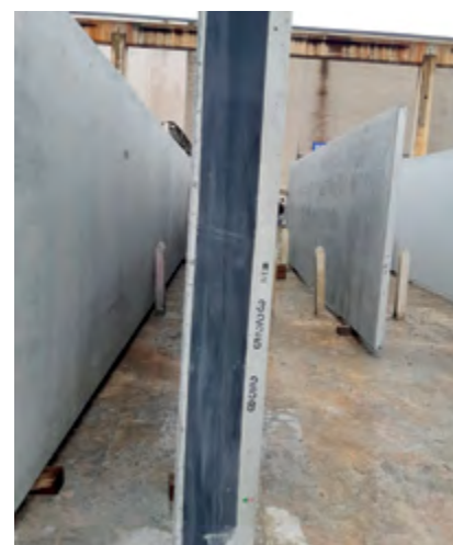
Gros œuvre bande entre prémurs
