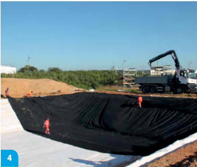
Dépliage de la géomembrane
