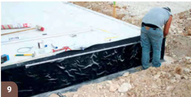
Mise en place d'un cordon de mastic pour sécuriser l'étanchéité au niveau du profil de fixation
