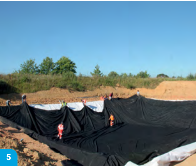
Ajustements de la géomembrane
