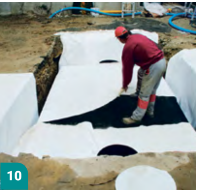
10 Pose du géotextile extérieur
