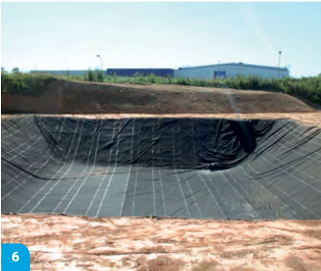
Ancrage et bassin finalisé
