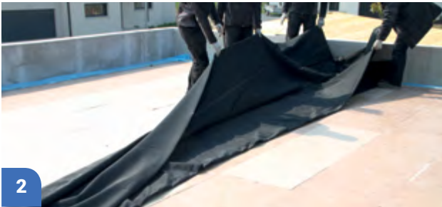
2 Dépliage de la membrane
