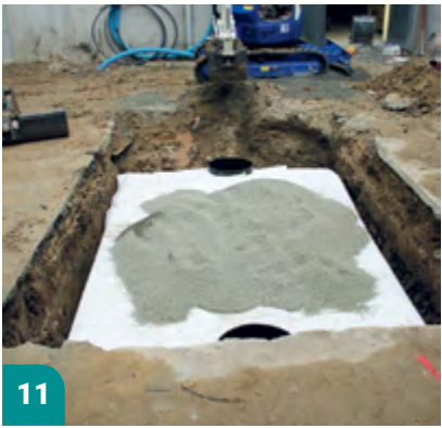
11 Finalisation du bassin enterré et recouvrement
