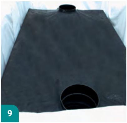
9 Découpage et positionnement des collerettes de sortie
