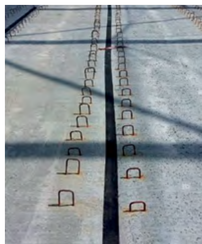
Étanchéité entre joints de prédalles
