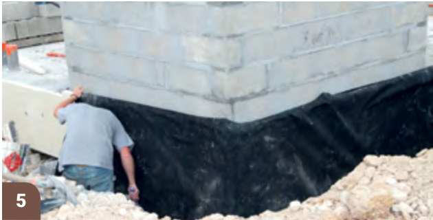
Positionnement de la protection de soubassement en EPDM
