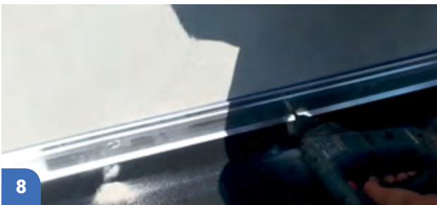
8 Fixation des solins, rives et couvertines
