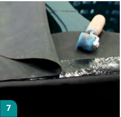
7 Positionnement et fermeture du couvercle grâce à l'adhésif double face
