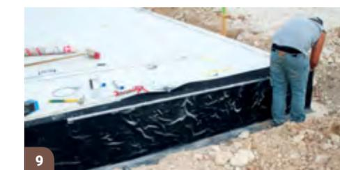
9 Mise en place d'un cordon de mastic pour sécuriser l'étanchéité au niveau du profil de fixation
