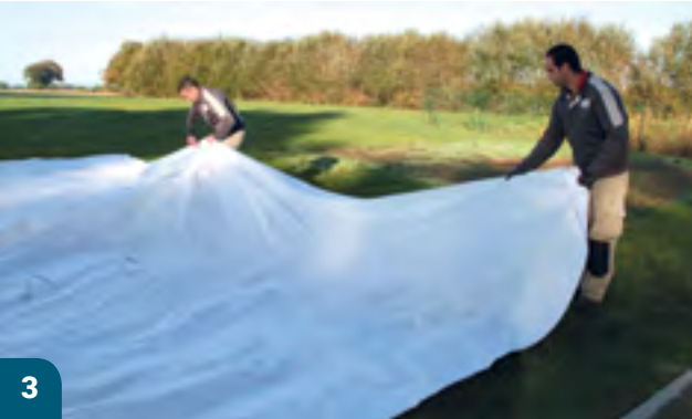
Pose du géotextile de protection avec agrafages
