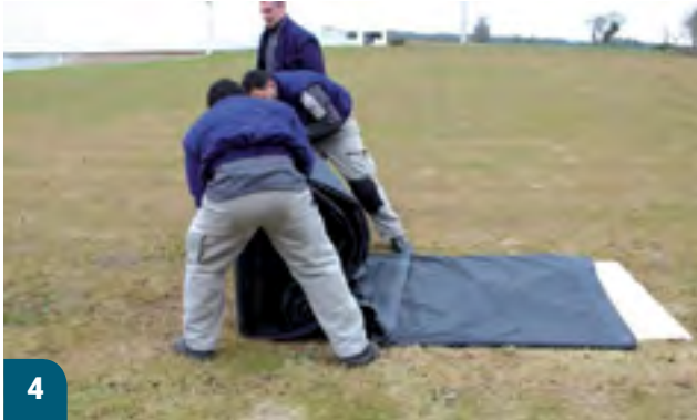
Déploiement de la citerne souple
