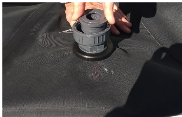
4. Visser la pièce intérieure de la vanne sur le téflon
