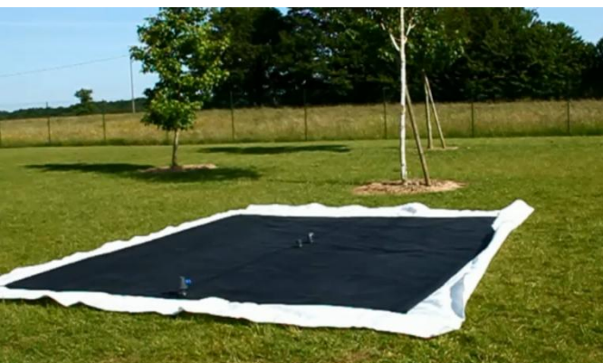
3. Positionnement de la citerne de façon à faire disparaître les plis et montage de la vanne de vidange
