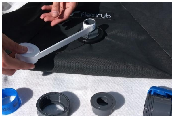
2. Appliquer sur l'axe fileté de la citerne 4 ou 5 tours de téflon
