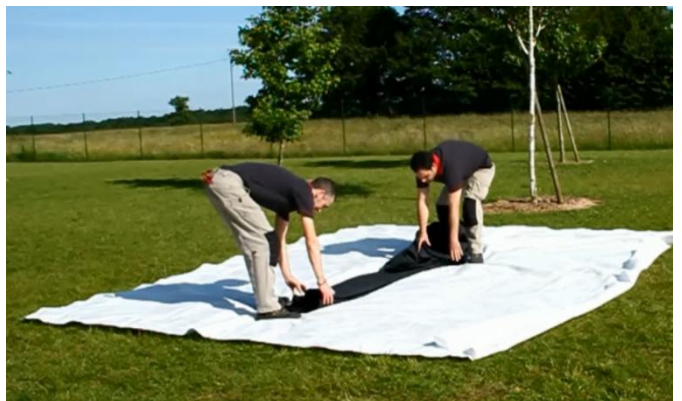
4. Déroulement de la citerne dans le sens de la longueur, puis déroulement dans le sens de la largeur
