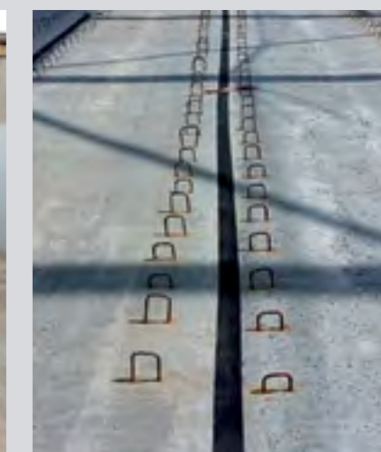
Étanchéité entre joints de prédalles
