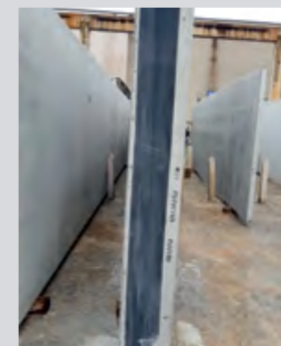
Gros œuvre bande entre prémurs
