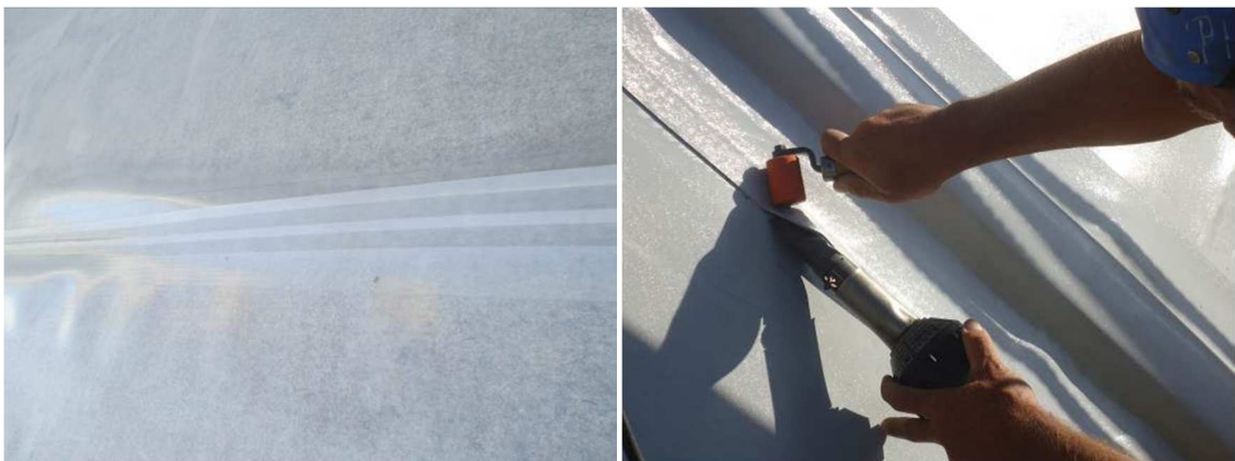
Photo 5 – Réalisation d'assemblages en PVC-P – Double soudure, soudure manuelle
