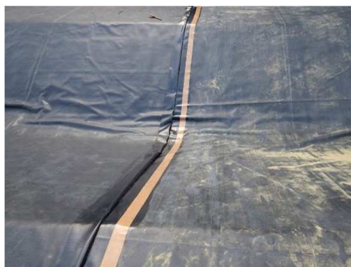
Photo 8 – Réalisation d’assemblages en EPDM
