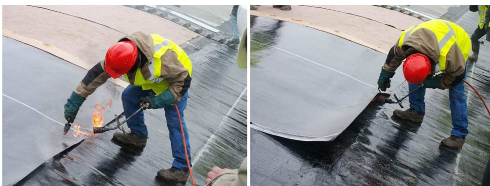
Photo 7 – Réalisation de soudures sur géomembranes bitumineuses
