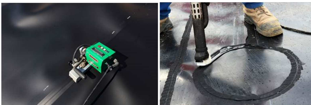
Photo 6 – Réalisation d’assemblages en PEHD – Double soudure, extrusion
